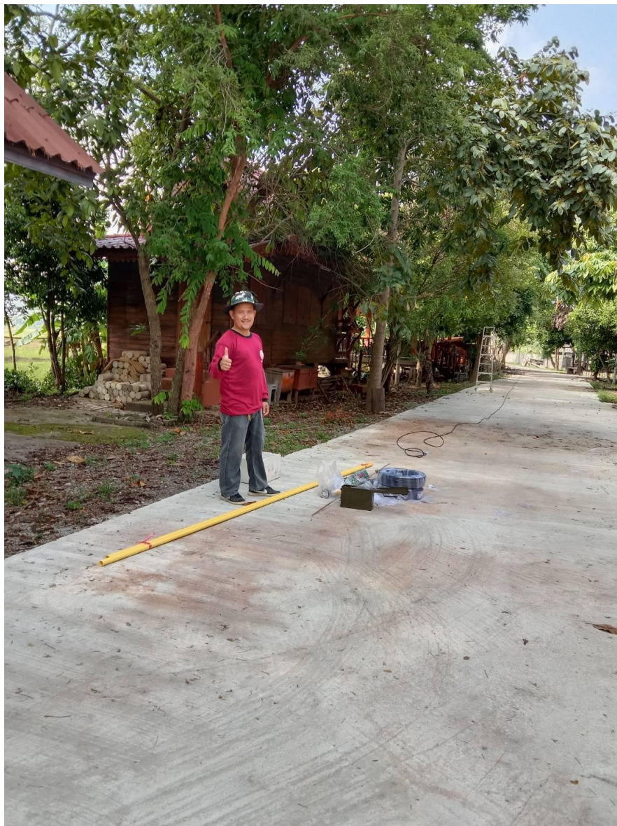
กิจกรรมปรับปรุงสถานที่ และไฟฟ้า สำหรับรองรับนักเรียนผู้สูงอายุ
